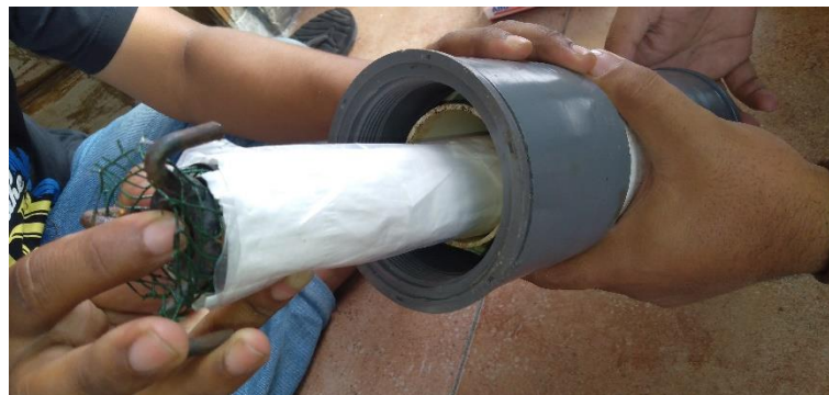
Gambar 3. 11 proses memasukkan kerangka filter kedalam tabung filter
