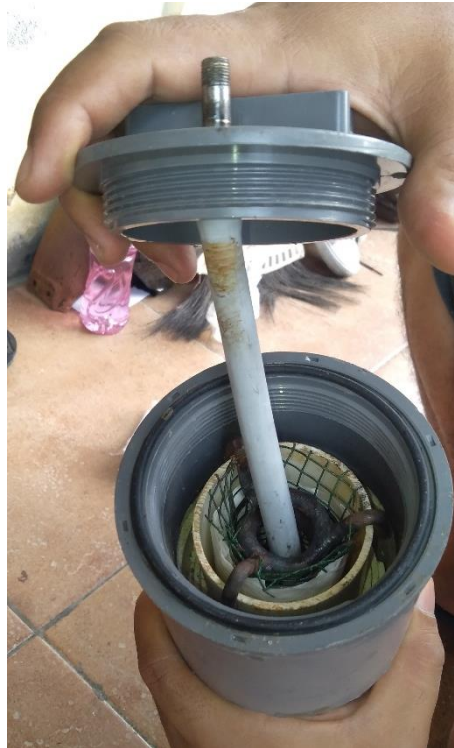
Gambar 3. 12 proses pemasangan tutup tabung filter
