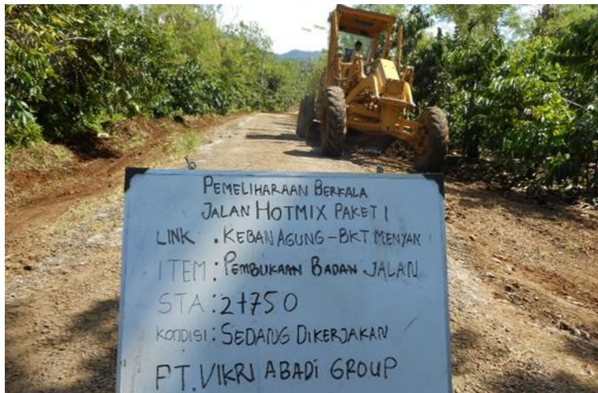
Gambar 5.1 dokumentasi di lapangan pada proyek keban agung-bukit menyan
