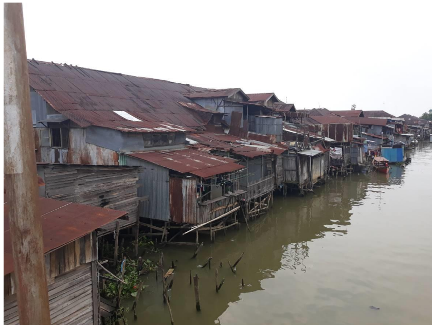
Gambar 3.7 : Kondisi eksisting permukiman tepi sungai
