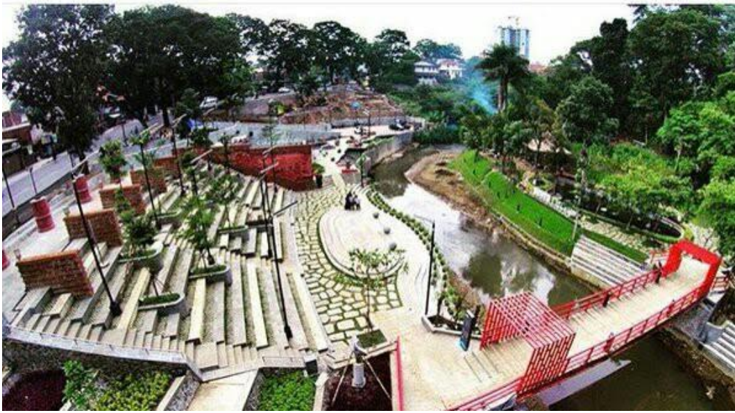
Gambar 3.7 Kondisi Teras Cikapundung Riverspot
