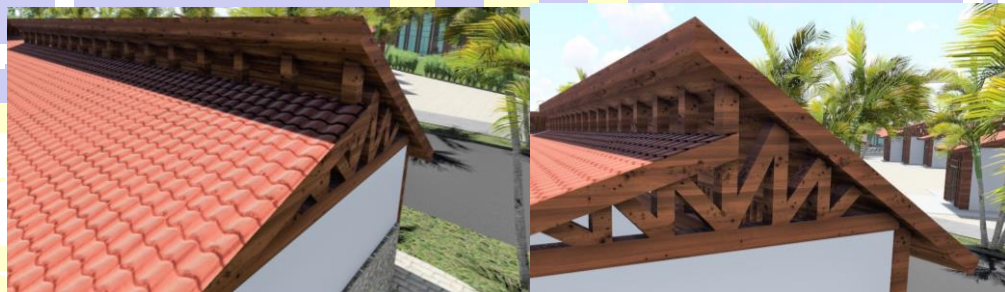
Gambar 4.27 Lubang di atap bangunan kios sebagai jalan masuk angin
