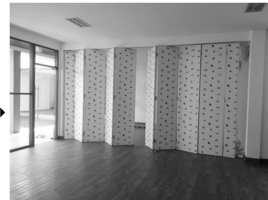
MENGGUNAKAN DINDING PARTISI MATERIAL MULTIPLEKS KAYU SEHINGGA DAPAT DI BONGKAR PASANG / MENJADI ROLLING DOOR SAAT MEMBUJUKKAN 2 RUANGAN SEKALIGUS
