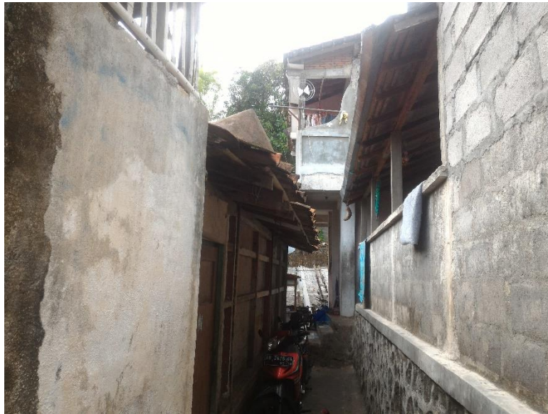
Gambar 2 - 2 Kondisi Kampung Gampingan RW 11
