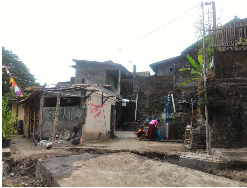
Gambar 2 - 3 Kondisi Kampung Gampingan RW 11
