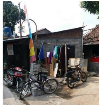
Gambar 2.2 Kondisi bangunan rumah tinggal di bantaran Kali Code Rw 18, Prawirodirjan
