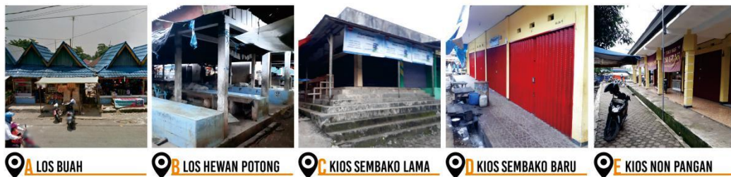
Gambar 2.10 Kondisi Bangunan Pasar Purwodadi
