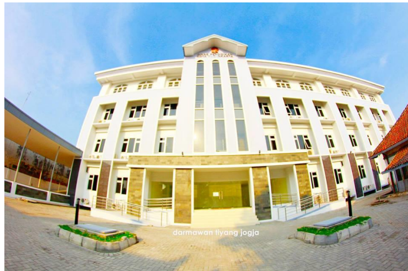
Gambar 5.1 Gambar Gedung Dinas Pendidikan Yogyakarta Sumber: https://www.google.com/
