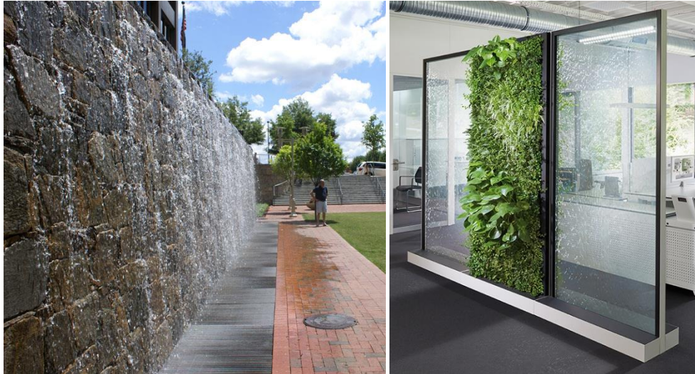
Gambar 3-19. Exterior Water Wall (kiri) dan Interior Water Wall (kanan).
