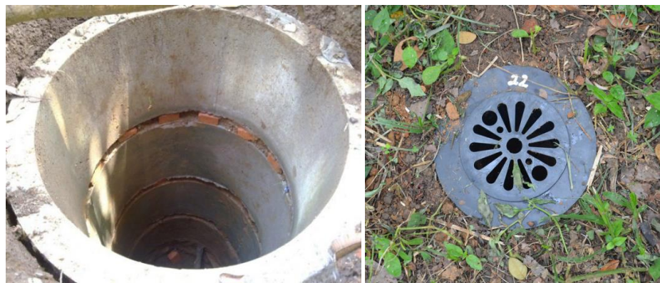
Gambar 3-28. Teknologi Sumur Resapan (kiri) dan Biopori (kanan).
