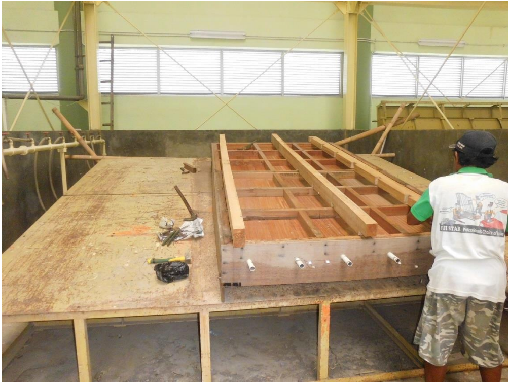
Gambar 4. 1 Proses Pembuatan Flume
