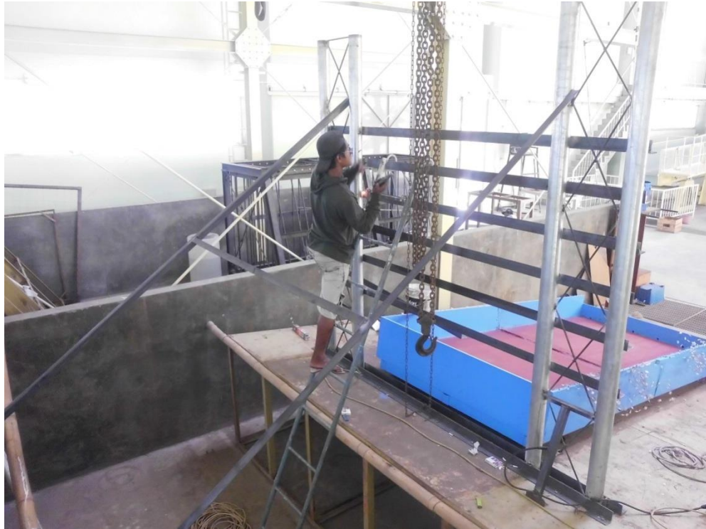
Gambar 4.4 Proses Pembuatan Penyangga Flume
