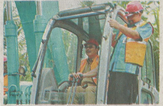
Bupati Hasto bersama Asisten I Purworejo Drs Murwanto mengoperasikan backhoe.
