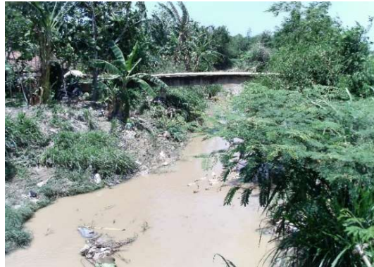
Gambar 5.24 Kondisi Penampang Melintang Sungai Bringin di Ruas Hilir
