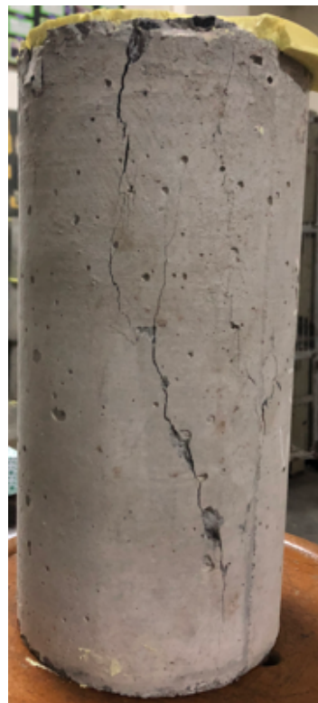
Gambar L-22.5 Hasil Pengujian Kuat Desak Beton
