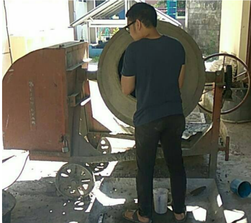
Gambar L-21.5 Pencampuran Beton
