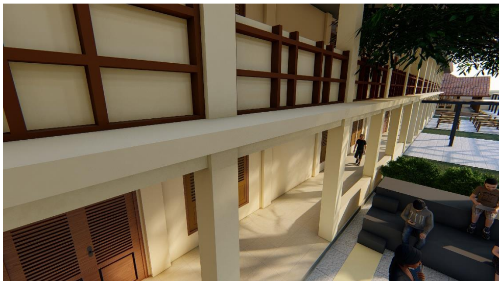
Gambar 6.3: Pelebaran plat lantai selasar lantai 2 sebagai shading .
