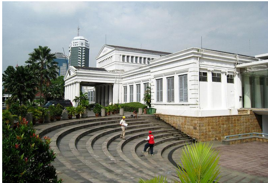
Gambar 2.44: Gedung Gajah Museum Selatan (Gedung Selatan)
