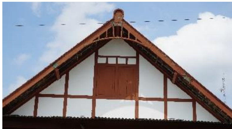
Gambar 2.25: Ornamen yang masih dipertahankan pada atap karena kondisinya masih sangat baik Sumber: Hapsari, 2017
