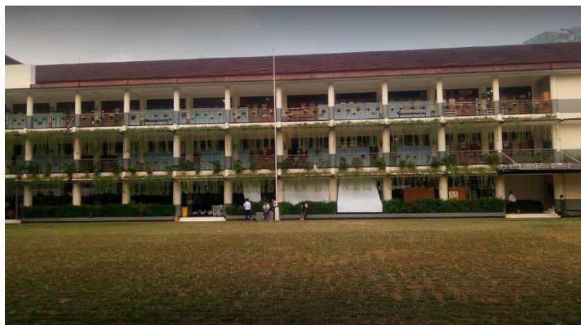
Gambar 2.48: Tampak depan bangunan kelas Sumber: Frenda Fauzia, 2018
