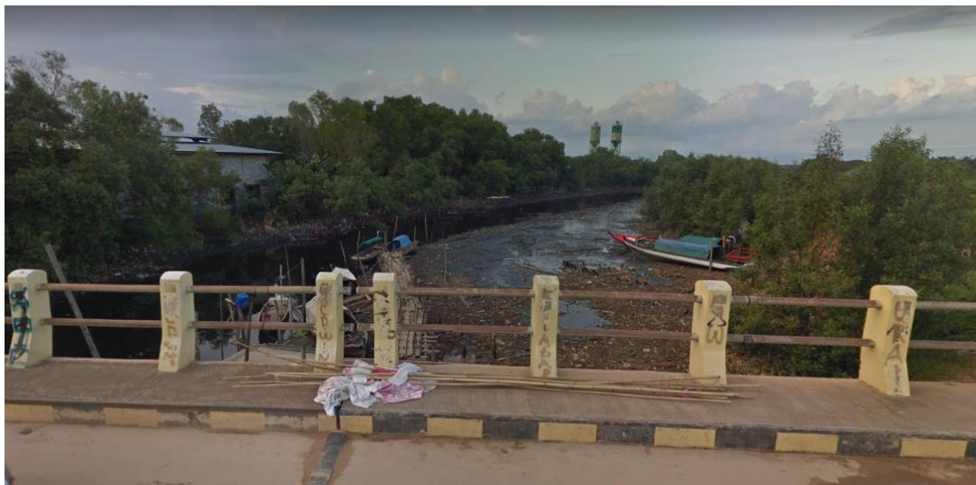
Gambar 1.2 . Jembatan Bengkong Sadai Sumber : Penulis. 2018
