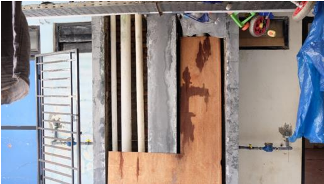
Gambar 2.7. (1) Bangunan Fisik Rusunawa Purus Kota Padang
