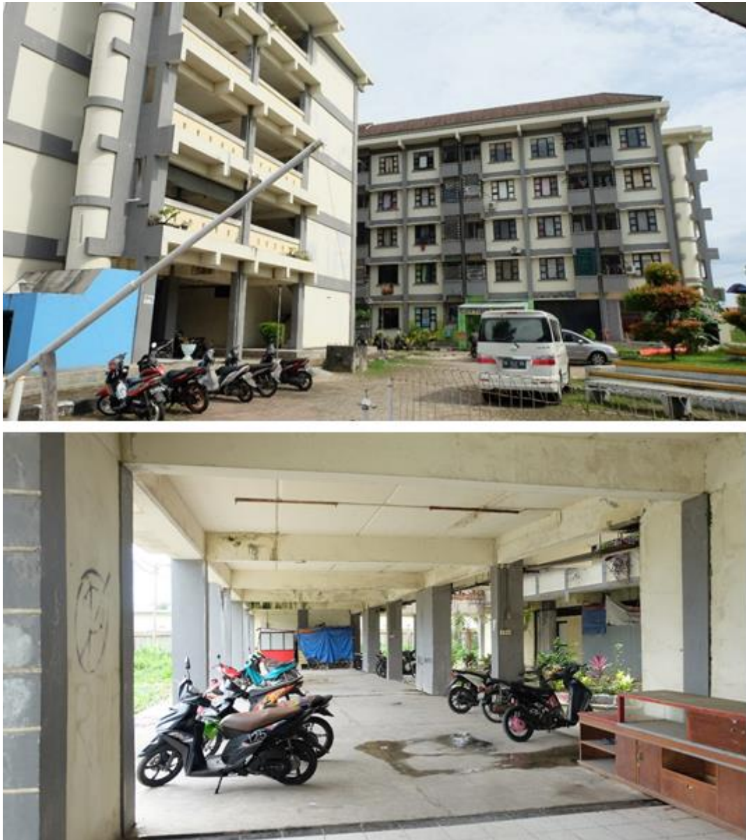
Gambar 2.7. (2) Ruang Parkir yang Tidak Cukup
