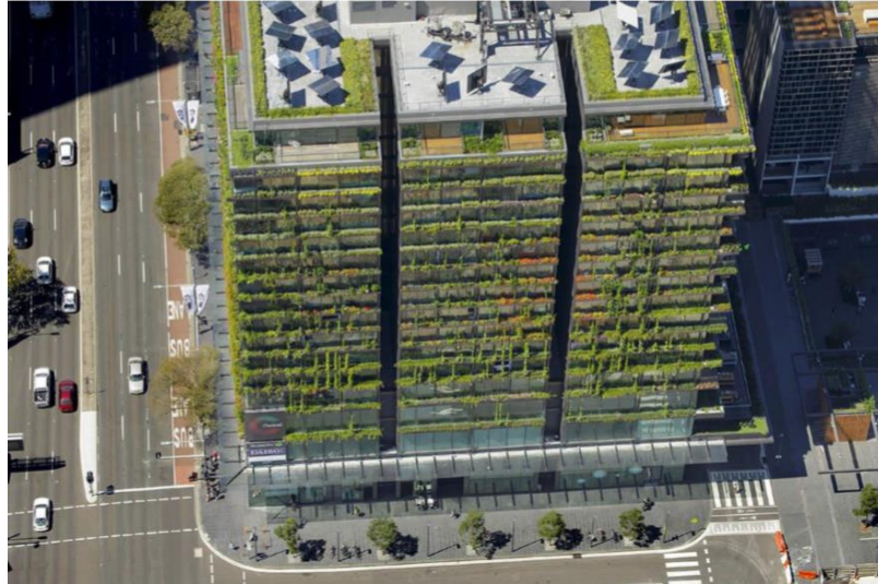
Gambar 2.12.1 Bangunan One Cetral Park
