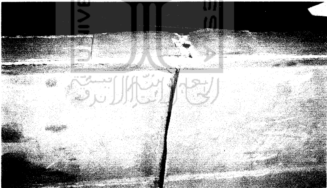
Gambar gelagar pelat delta mengalami tekuk lokal pada pelat sayap.
