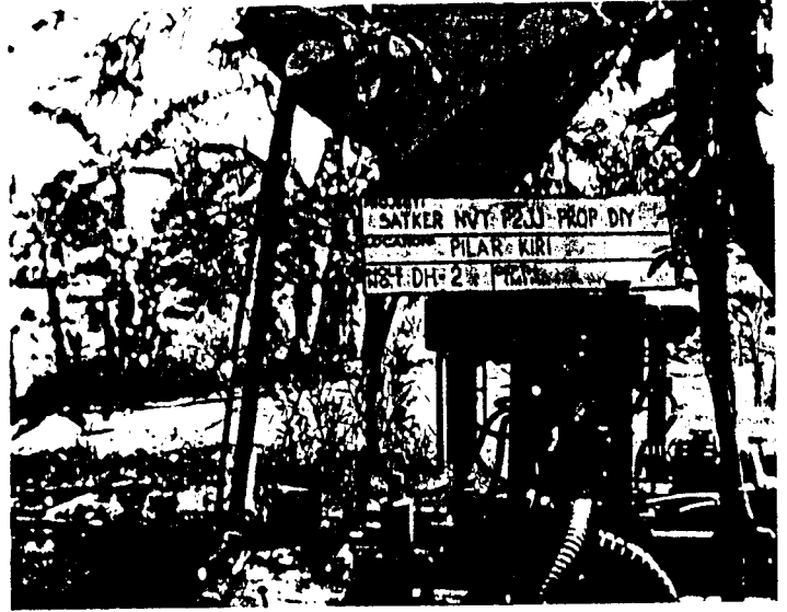
Foto 2. Lokasi titik bor DH-2 (pilar kiri)
