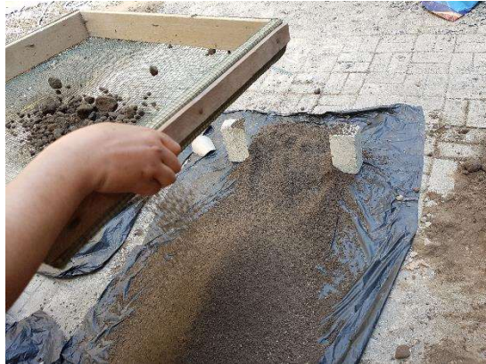
Penyaringan Agregat Halus
