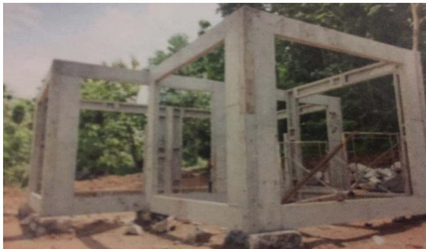
**Gambar 3.4 Struktur Rangka Rumah Sistem RISHA**
