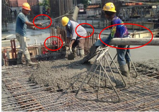
**Gambar 5.2 Kegiatan pengecoran Pelat dan Balok**
