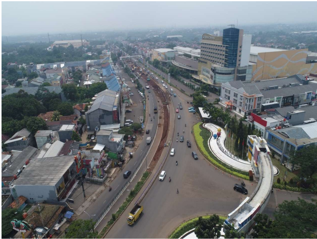
Gambar 1.1 Lokasi Jl. Transyogi, Proyek Jalan Tol Cimanggis-Cibitung (sumber: PT. SANPALA INTICON, 2018)
