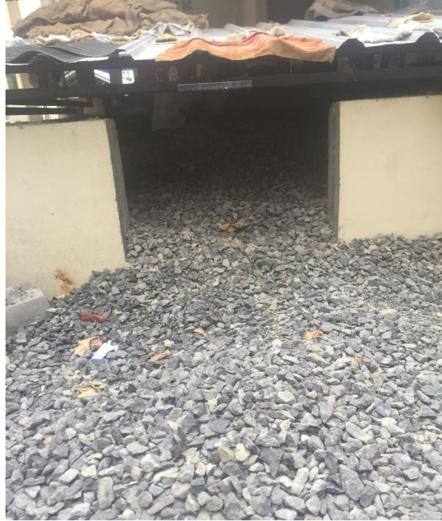
Gambar L-2.1 Agregat Kasar dari Clereng, Kulon progo
