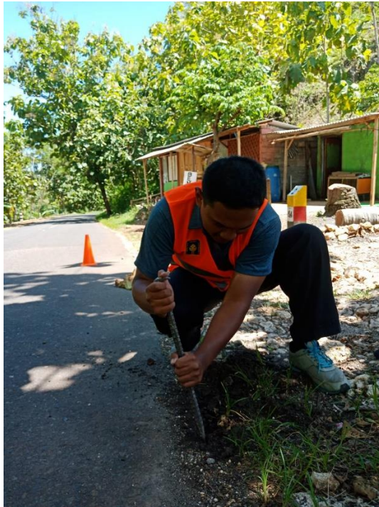
Gambar L-4.4 Galian Pinggir Jalan Untuk Mengetahui Ketebalan Aspal
