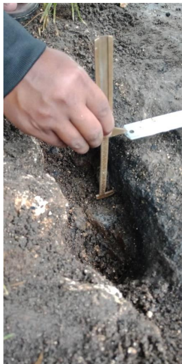
Gambar L-4.5 Mengukur Ketebalan Aspal
