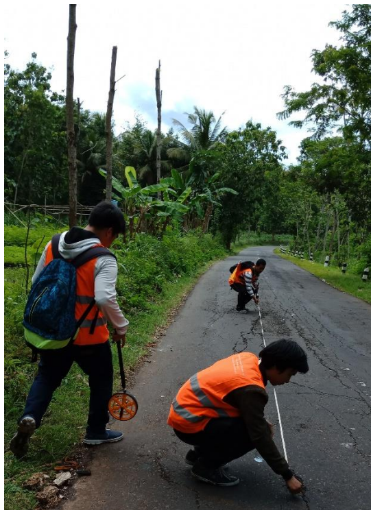
Gambar L-4.3 Survei Kerusakan Jalan Metode PCI Jalan Baron
