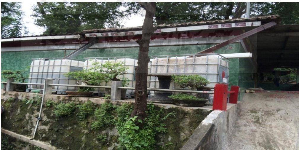
Gambar 4.18.Kondisi Sanitasi Desa Mbendo
