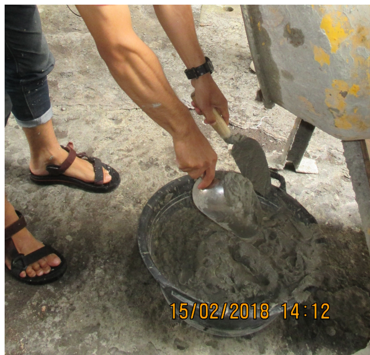
Lampiran L-1. 10 Beton busa ( foam ) hasil penambahan busa ( foam ) ke dalam campuran mortar
