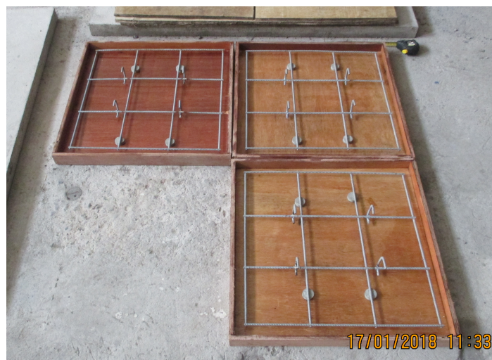
Lampiran L-1. 4 Pemasangan wire mesh sebelum pengecoran lapisan kulit ( skin ) panel dinding benda uji tipikal 1 (Uji tekan)
