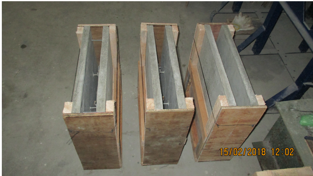
Lampiran L-1. 7 Persiapan pengecoran lapisan inti ( core ) benda uji panel dinding tipikal 1 (Uji tekan)
