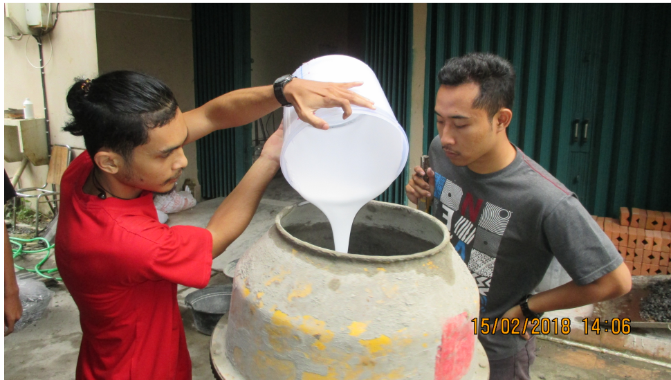
Lampiran L-1. 9 Proses penambahan busa ( foam ) ke dalam campuran mortar
