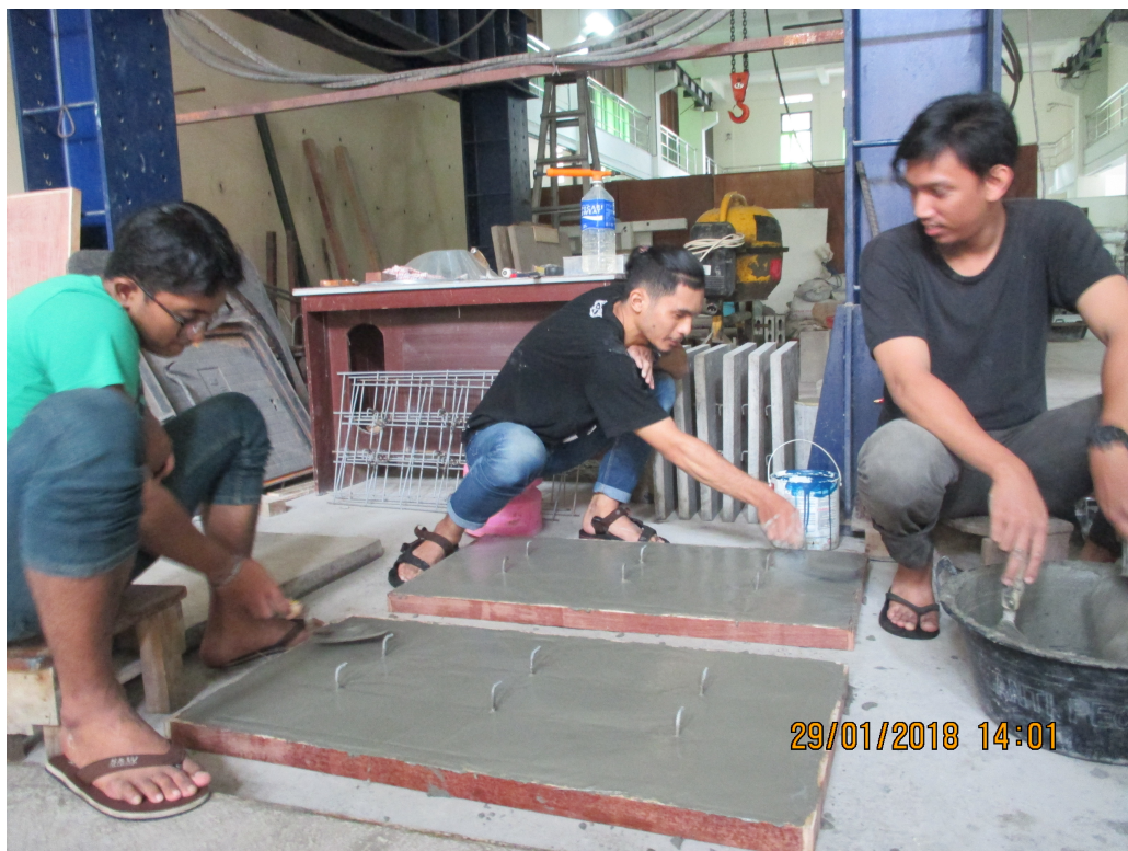
Lampiran L-1. 6 Proses pengecoran lapisan kulit ( skin ) panel dinding benda uji tipikal 2 (Uji lentur)
