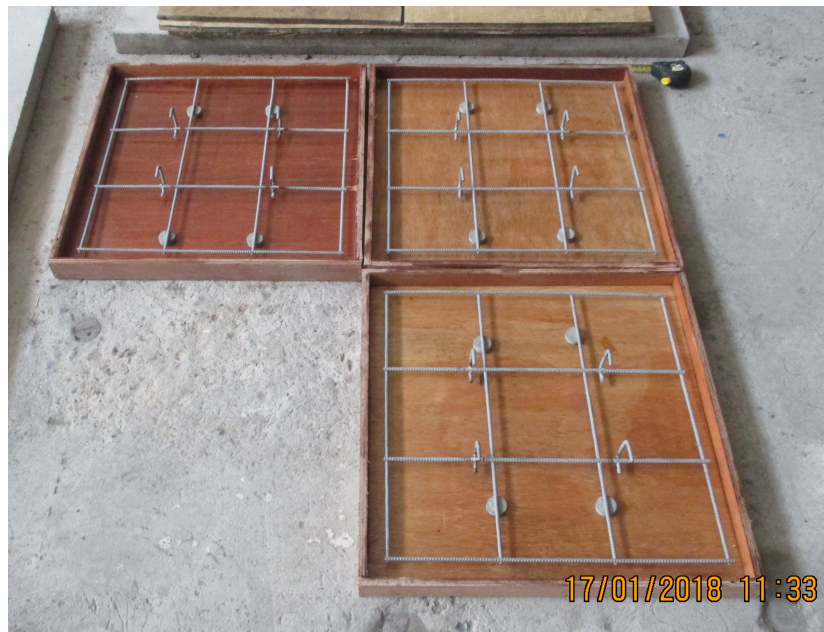
Gambar 4.16 Pemasangan tulangan jaring kawat pada cetakan lapisan kulit ( skin ) panel dinding
