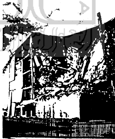
Gambar 2.7 Kerusakan akibat peristiwa liquefaction
