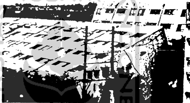
Gambar 2.7 Kerusakan akibat peristiwa liquefaction
