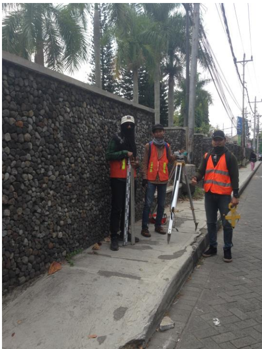
Lampiran 26. Foto Lokasi Jalan Teknik Utara dan Tim Surveyor Dengan Alat Ukur ( Waterpass , Rambu dan Rollmeter ). (Sumber : kamera surveyor)
