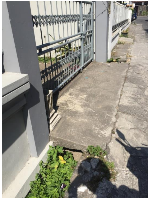
Lampiran 21. Foto Lokasi Jalan Ladrang. (Sumber : kamera surveyor)
