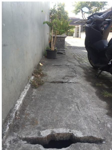
Lampiran 6. Foto Lokasi Jalan Pandega Wreksa. (Sumber : kamera surveyor)
