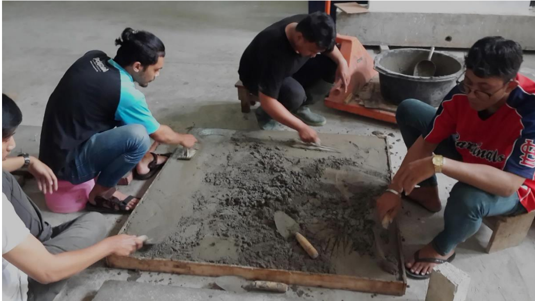
Gambar L-2.2 Proses Pencetakan Dinding Panel Papercrete
