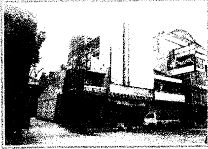
Gambar 1.6. Bangunan di utara Site ( Kompleks pertokoan )
