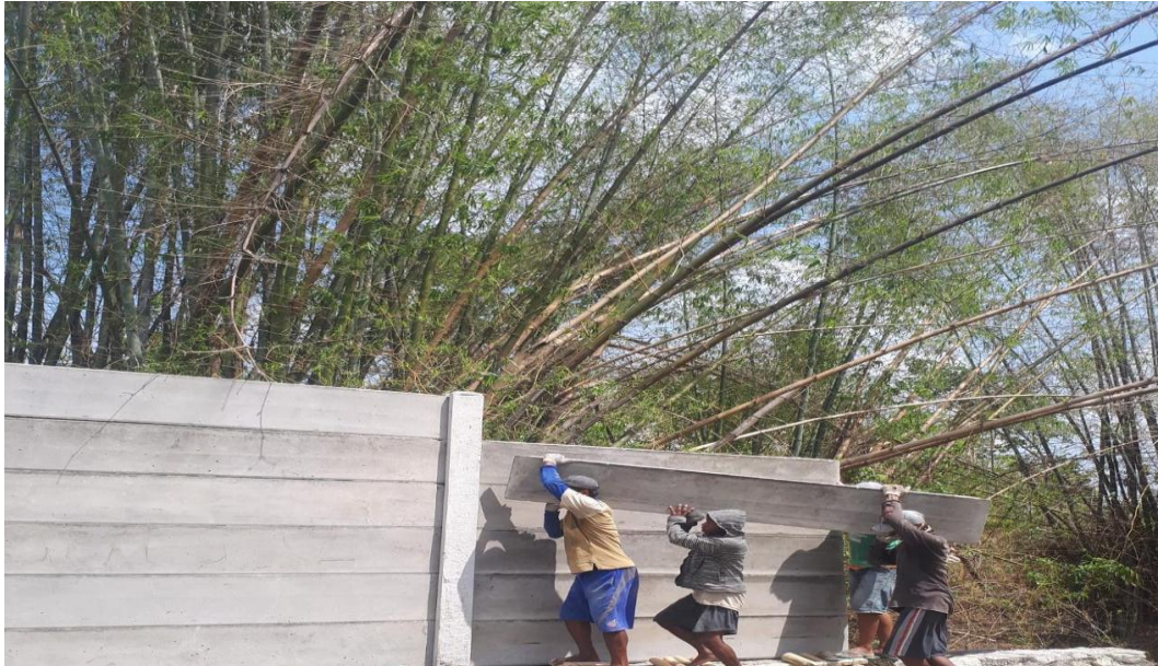
Gambar L 5.1 Pemasangan Pagar Beton Precast
