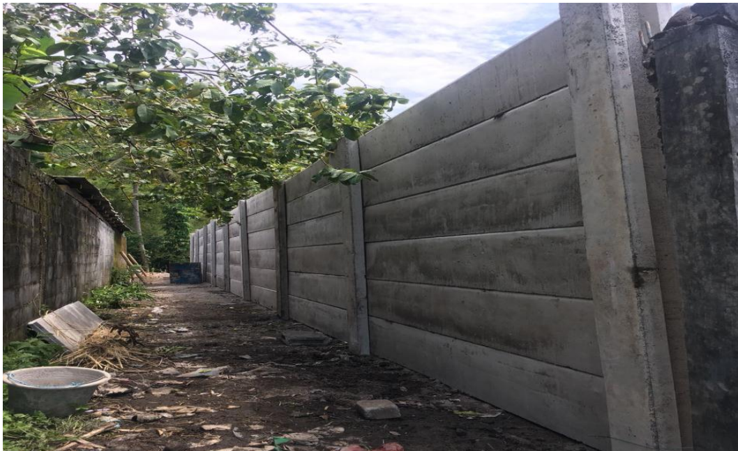
Gambar L 5.2 Pagar Beton Precast Yang Sudah Terpasang Di Lapangan
