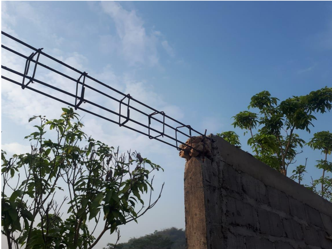
Gambar L 6.1 Sloof Atas Pagar Batako Konvensional
