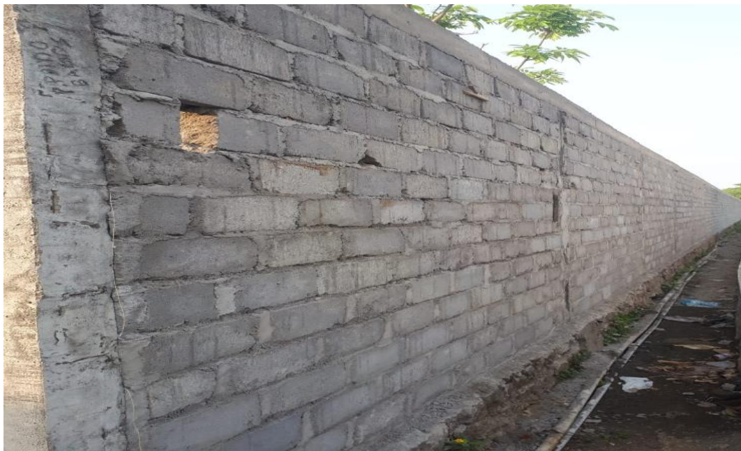
Gambar L 6.2 Pagar Batako Konvensional Terpasang Di Lapangan
