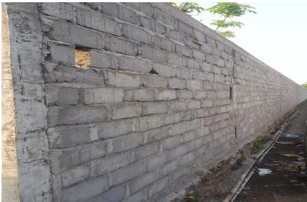
Gambar 5.2 Pemagaran pagar batako konvensional pada Proyek Pemagaran Gudang PT. Nusa Jaya Concretama
