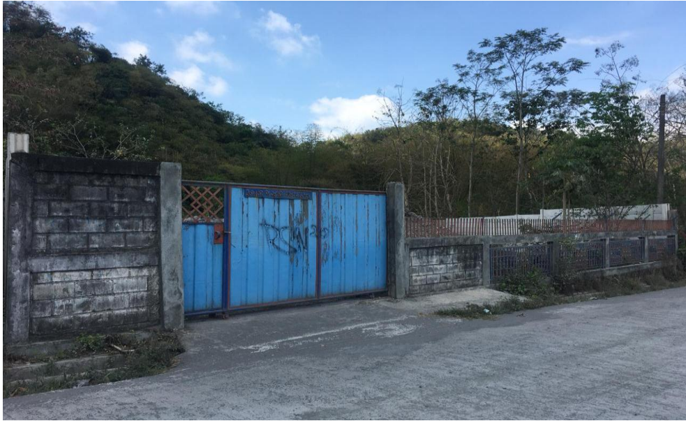
Gambar 1.3 Gambaran Lokasi Proyek Sesudah Dilakukan Pekerjaan Pemagaran
