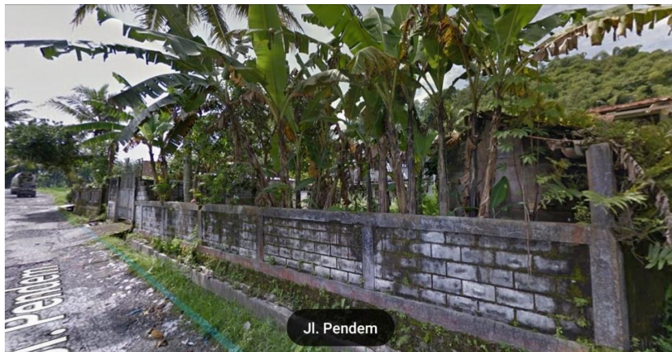
Gambar 1.2 Gambaran Lokasi Proyek Sebelum Dilakukan Pekerjaan Pemagaran
