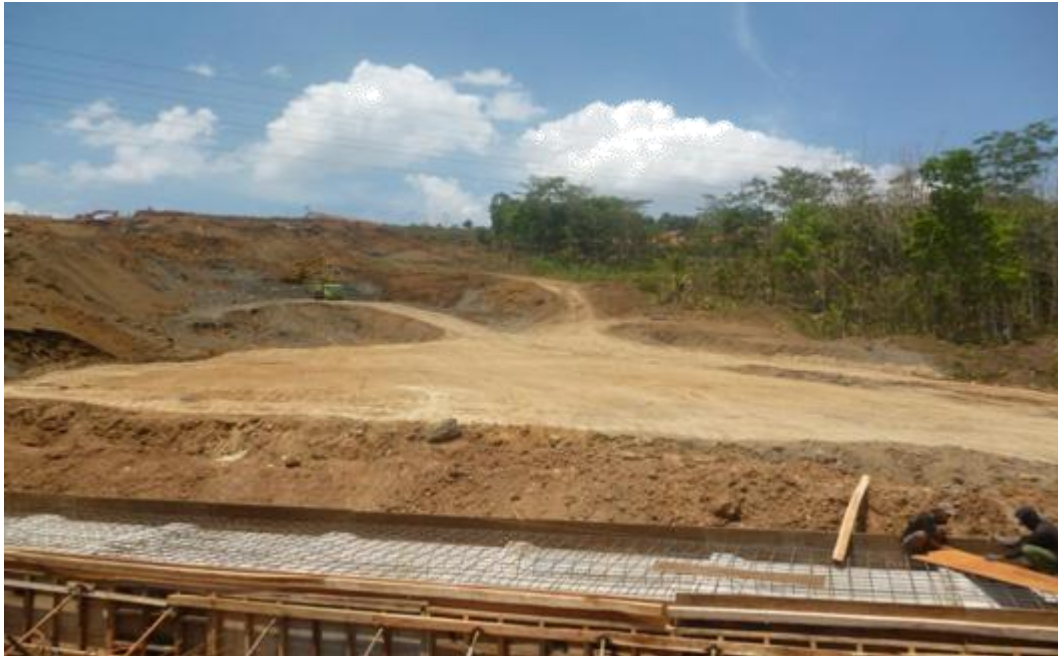
Gambar L-1.2 Lokasi Galian dan Timbunan Jalan pada Sta. 2+175 s/d 2+500
