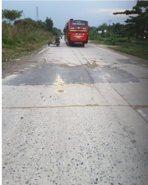
Gambar L-2.1 Jalan Pekanbaru – Siak km 12 + 700
