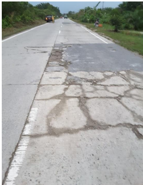
Gambar L-2.2 Jalan Pekanbaru – Siak km 13
