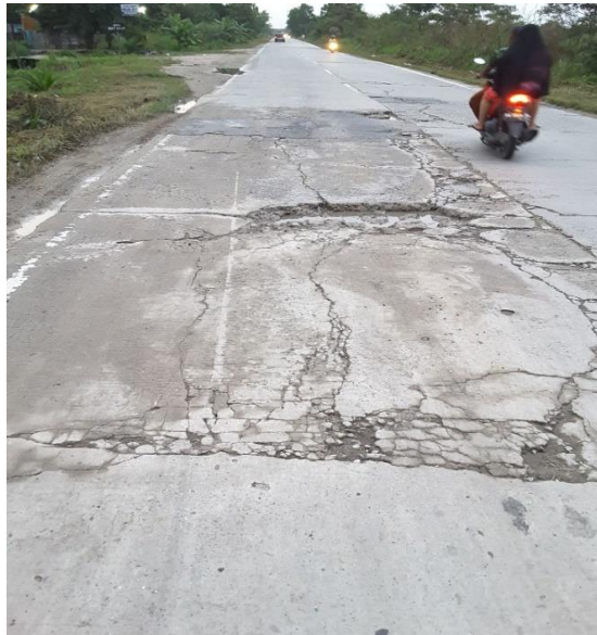
Gambar L-2.3 Jalan Pekanbaru – Siak km 13 + 800
