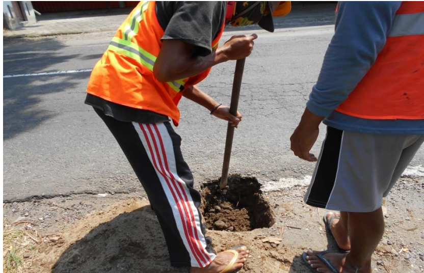
Gambar 5.9 Penggalian Bahu Jalan (Titik 5)
