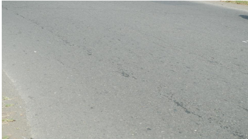
Gambar 5.27 Kondisi Permukaan Jalan Sultan Agung Segmen 9 (Arah Barat)
