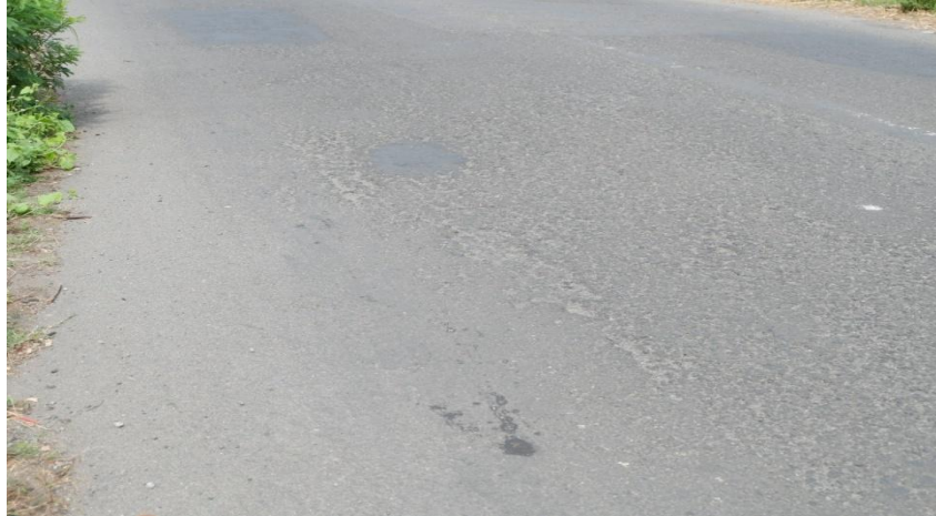
Gambar 5.21 Kondisi Permukaan Jalan Sultan Agung Segmen 6 (Arah Barat)
