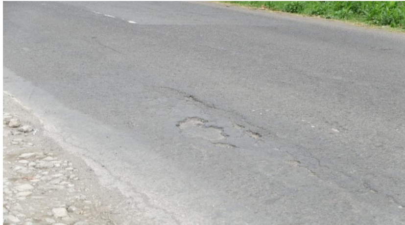
Gambar 5.19 Kondisi Permukaan Jalan Sultan Agung Segmen 5 (Arah Barat)
