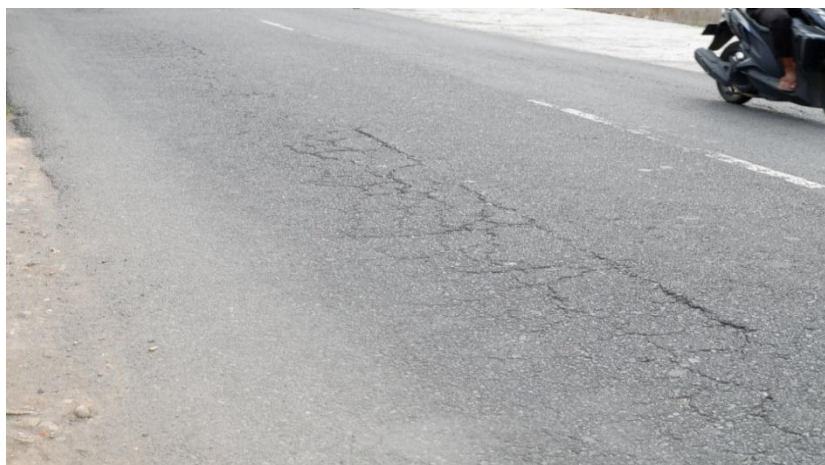
Gambar 5.35 Kondisi Permukaan Jalan Sultan Agung Segmen 13 (Arah Barat)
