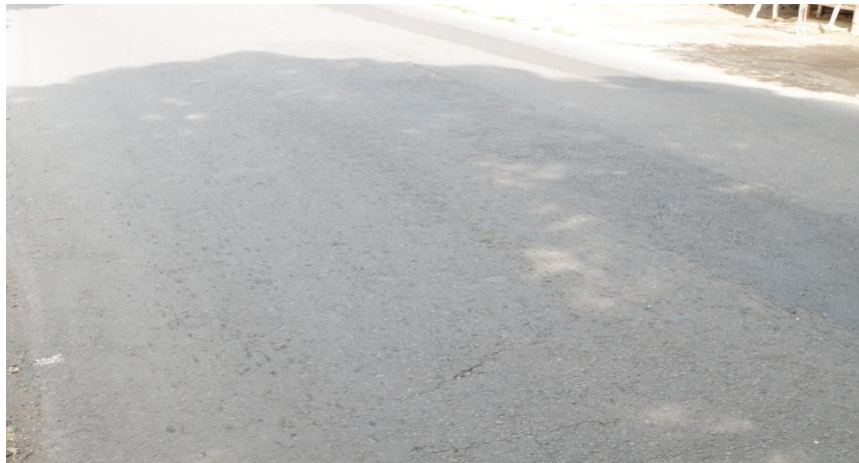
Gambar 5.29 Kondisi Permukaan Jalan Sultan Agung Segmen 10 (Arah Barat)
