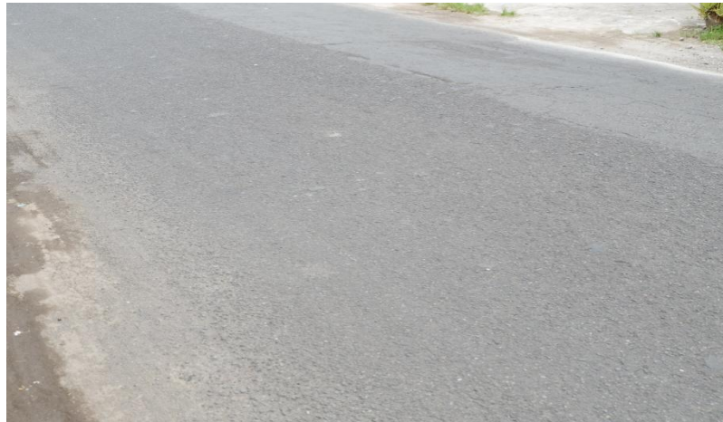
Gambar 5.11 Kondisi Permukaan Jalan Sultan Agung Segmen 1 (Arah Barat)
