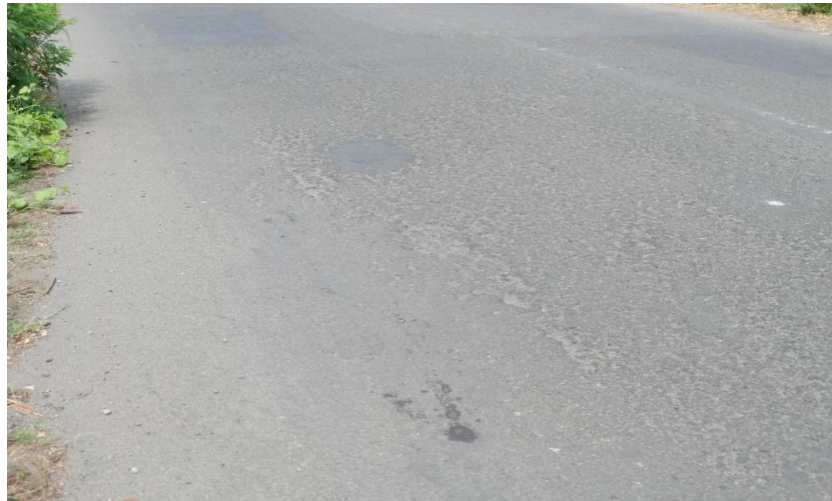
Gambar 5.25 Kondisi Permukaan Jalan Sultan Agung Segmen 8 (Arah Barat)
