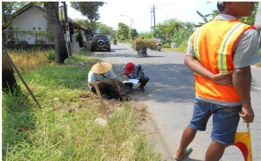
Gambar 5.6 Penggalan Bahu Jalan (Titik 2)
