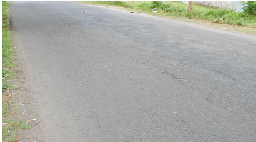
Gambar 5.23 Kondisi Permukaan Jalan Sultan Agung Segmen 7 (Arah Barat)
