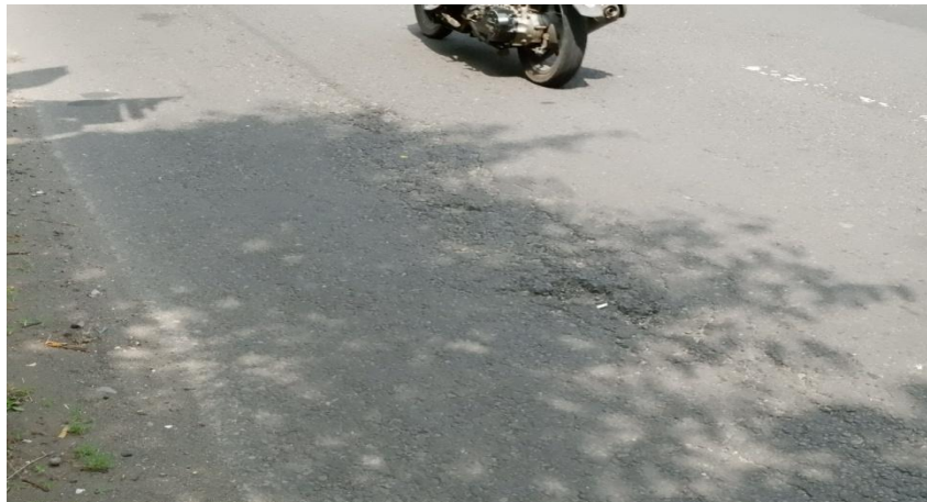
Gambar 5.33 Kondisi Permukaan Jalan Sultan Agung Segmen 12 (Arah Barat)
