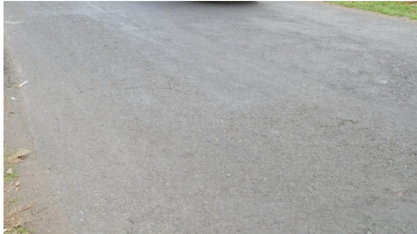
Gambar 5.17 Kondisi Permukaan Jalan Sultan Agung Segmen 4 (Arah Barat)
