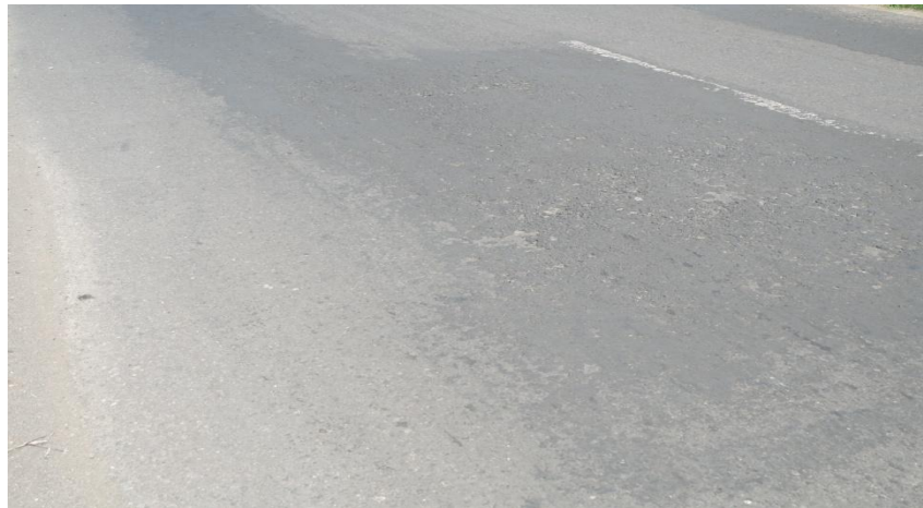
Gambar 5.39 Kondisi Permukaan Jalan Sultan Agung Segmen 15 (Arah Barat)
