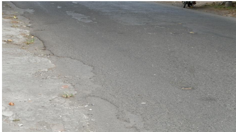
Gambar 5.15 Kondisi Permukaan Jalan Sultan Agung Segmen 3 (Arah Barat)
