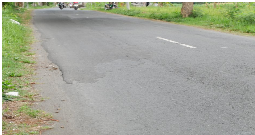
Gambar 5.37 Kondisi Permukaan Jalan Sultan Agung Segmen 14 (Arah Barat)
