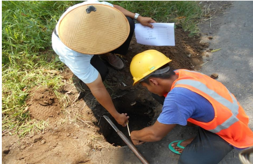
Gambar 5.7 Penggalian Bahu Jalan (Titik 3)
