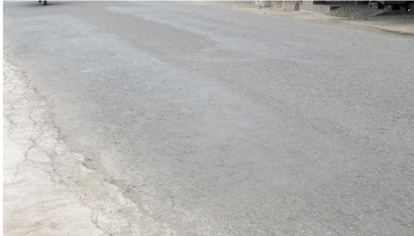
Gambar 5.13 Kondisi Permukaan Jalan Sultan Agung Segmen 2 (Arah Barat)
