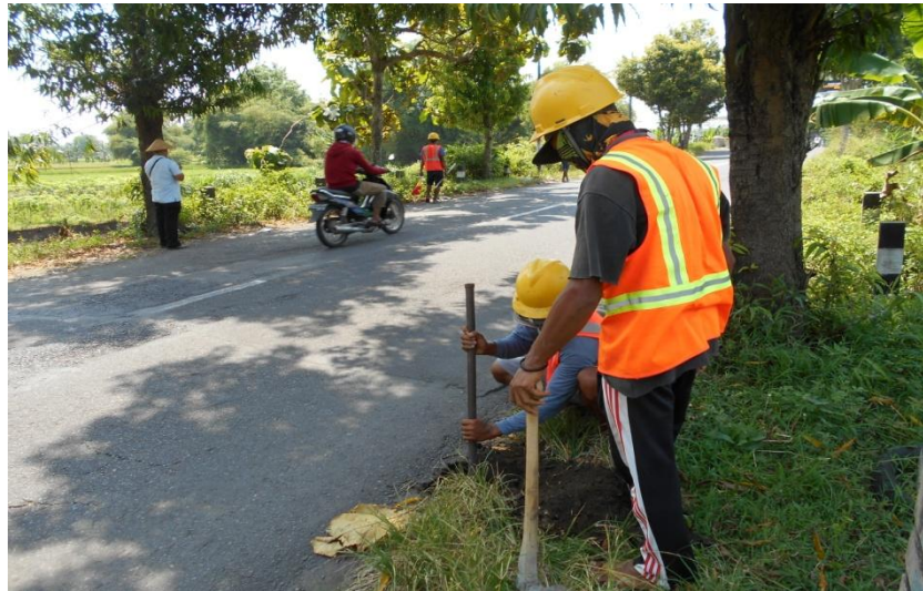
Gambar 5.5 Penggalan Bahu Jalan (Titik 1)
