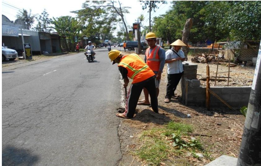
Gambar 5.8 Penggalian Bahu Jalan (Titik 4)
