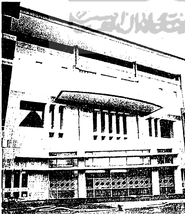
Gambar 2.26 Salah satu facade bangunan yang sederhana yang menggunakan bukaan-bukaan yang disusun berirama dan seimbang Sumber : Bayt Al-Qur'an dan Museum Istiqlal
