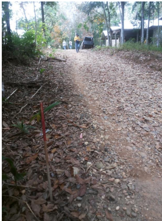
Gambar 5.1 Lokasi Proyek Pembangunan Jalan Tapin, Banjarmasin
