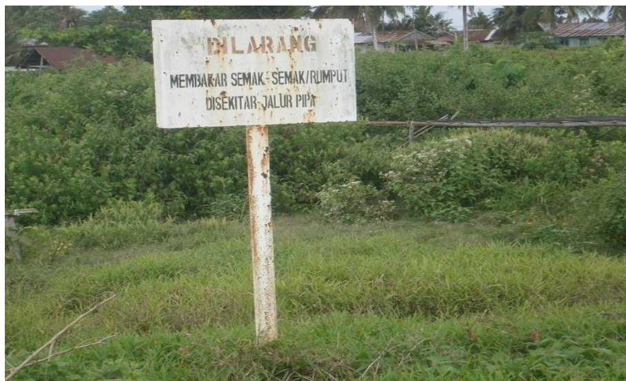
Gambar 5.9 Tanda Peringatan Pada Jalur Pipa Penyalur Bawah Tanah
