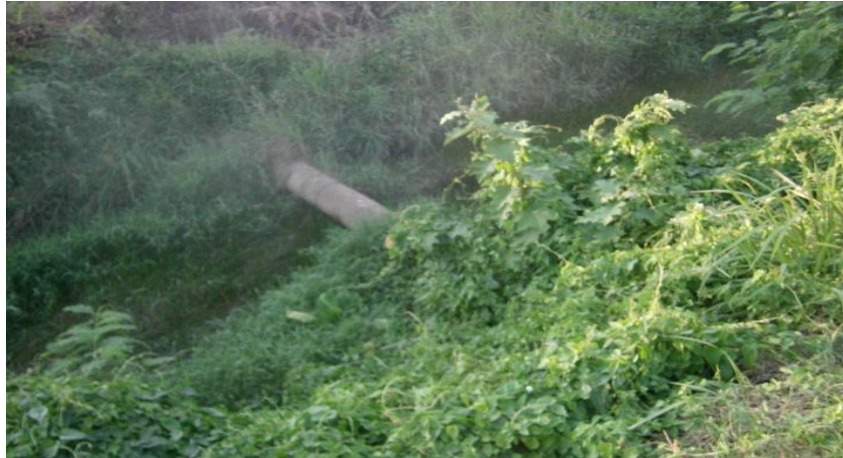
Gambar 5.3 Kondisi Pipa Penyalur yang Menyeberangi Parit
