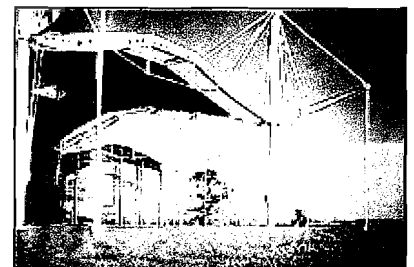
Gbr. I.5 Renault Sales Headquarters, Swindon. Pemakaian struktur atap gantung. Sumber: Internet
