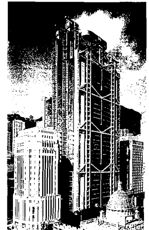
Gbr. I.4 Hongkong Shanghai Bank. Ekspos struktur dan crane dibagian atas yang memperlihatkan eternal construction , merupakan ekspresi kekokohan. Sumber: Peter Gossel, Gabriele L, "Architecture In The Twentieth Century", Taschen, hal 330.
