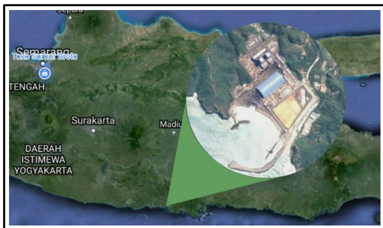
Gambar 4.1 Lokasi PJB UBJOM PLTU Pacitan
