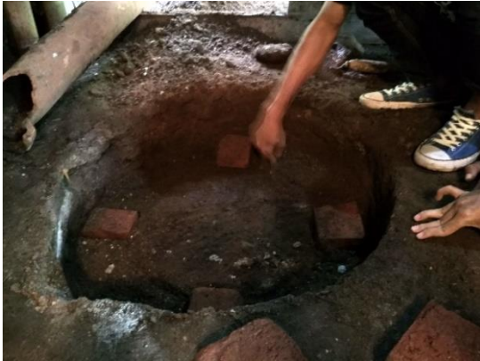
Pemasangan pondasi tungku
