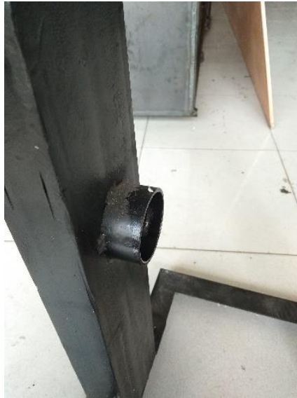
Gambar 3.10 Pembuatan Bushing dan Penyambungan
