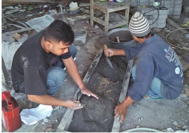
**Gambar L-4.1 Proses Pencampuran Bahan Penyusun *Paving Block***
