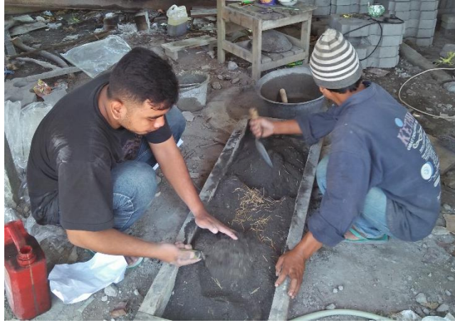
Gambar L-4.1 Proses Pencampuran Bahan Penyusun Paving Block
